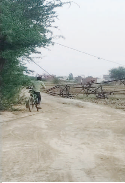
पुन्हाना से थयीज जा रही बिजली की हाईवोल्ट लाइन का गिरा हुआ टावर।
